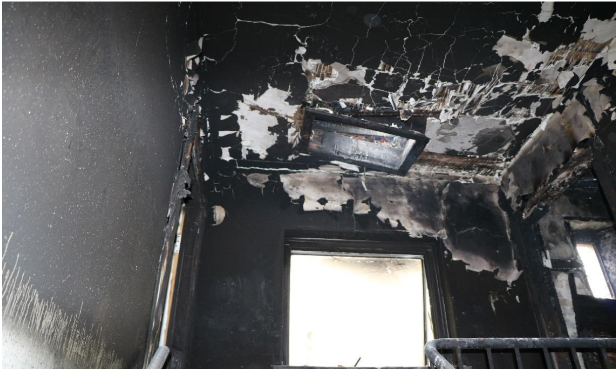
Billede fra opgang – lejligheden ses til højre – bemærk forskallingsbrædder og rørmåtter
