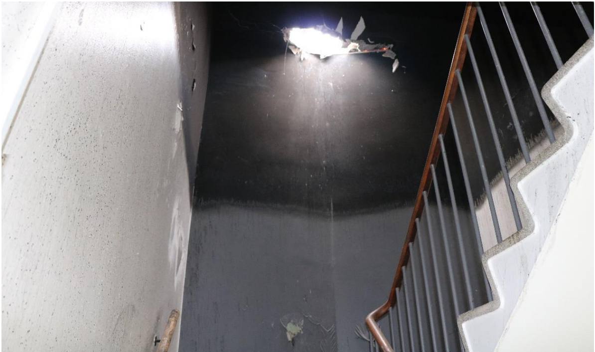
Gennembrænding i trappeopgang op mod tagkonstruktionen
