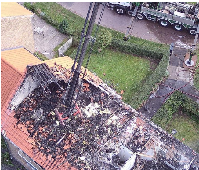
Billede fra indsatsen, hvor der samarbejdes mellem drone- og kranfører. Med det blotte øje er det ikke muligt at se, hvor der umiddelbart er gløder og ildlommer.
