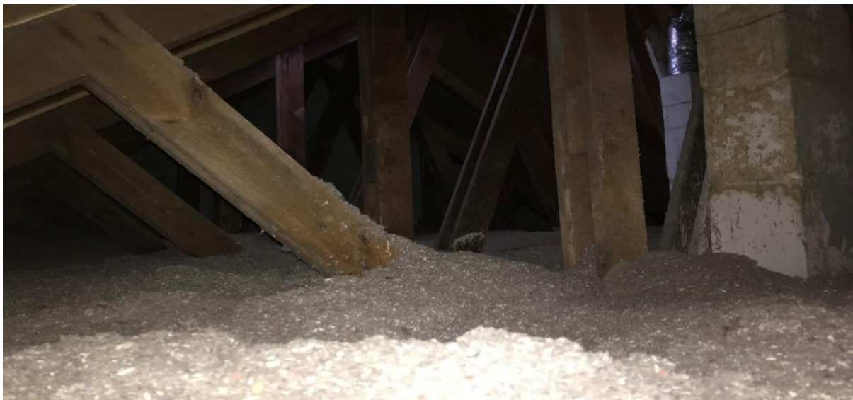
Melagervej 9 – tagkonstruktion efterisoleret med papiruld. (Billedet er taget i nabobygningen til nummer 5, der konstruktionsmæssigt er identisk)
